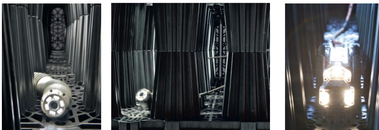
Рисунок 3.4 – Осмотр внутреннего состояния резервуара камерами видеоинспекции
