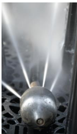
Рисунок 4.1 – Гидродинамическая промывка резервуаров ACO StormBrixx
